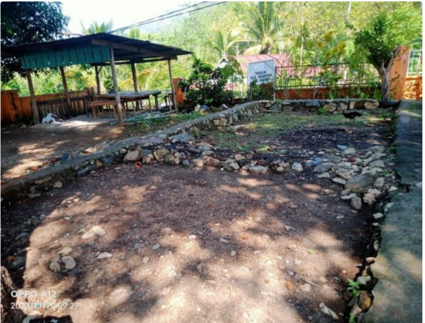
Macet, Baru Pondasi Bangunan Musholla selesai di SDN 19 Batu Napara Balocci
